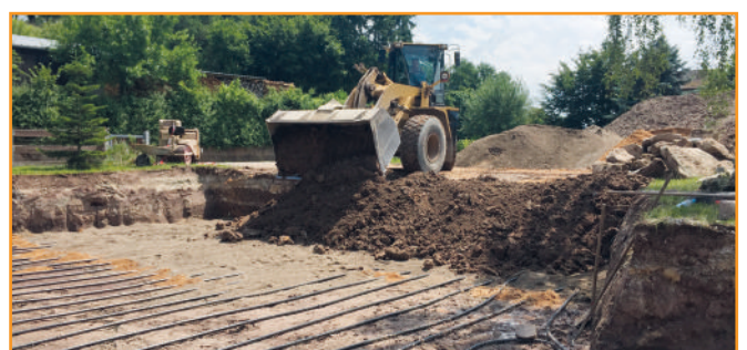
Die Bilderstrecke zeigt von oben nach unten den Ablauf (Grube, Verlegung, Anschluss), Quelle: Fischer GeoPlan GmbH
