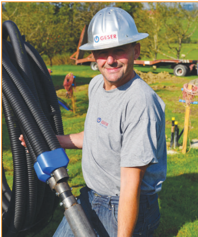
Stefan Geser mit JANOtherm powerwave Doppel-U-Sonde. Quelle: Geser Erdwärme GmbH & Co KG
