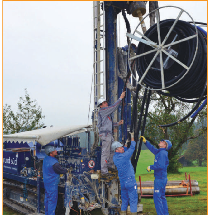
Die Bohrmannschaft war sichtlich beeindruckt vom einfachen Einbau. Für das Foto wollte jeder Hand mit anlegen. Quelle: Geser Erdwärme GmbH & Co KG
