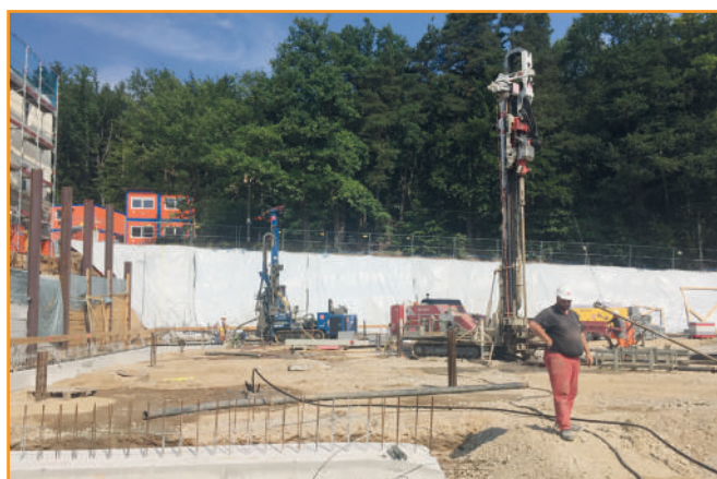
Ein Blick auf die beiden Bohranlagen Quelle: Fischer Spezialbaustoffe GmbH
