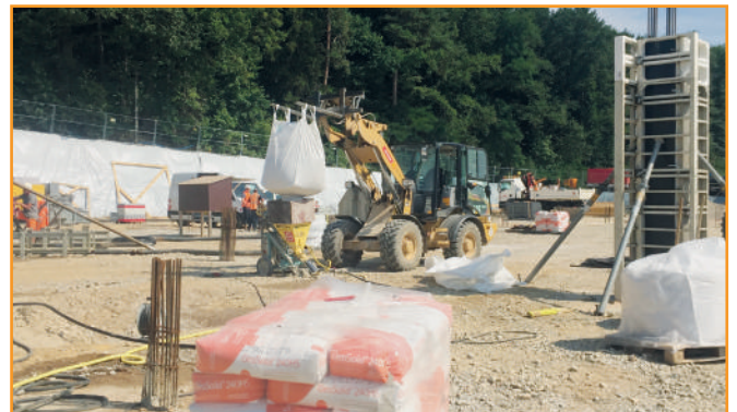
Der Radlader lässt den Baustoff aus dem BigBag in den Trichteraufsatz der Marke Eigenbau rieseln Quelle: Fischer Spezialbaustoffe GmbH
