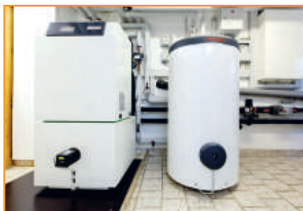
Blick in den Heizungskeller mit der Wärmepumpe mit Pufferspeicher. Quelle: Max Weishaupt GmbH
