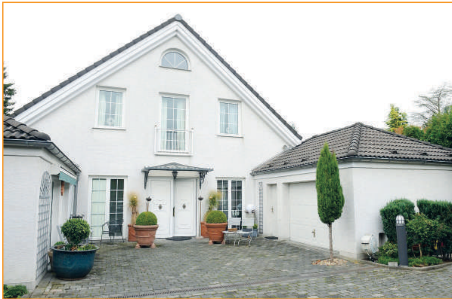
Bestandsimmobilie nach der Umrüstung von Öl auf Erdwärme, die Bohrungen sind hinter dem Gebäude abgeteuft worden und an den Technikraum angebunden. Quelle: Bundesverband Wärmepumpe e.V.
