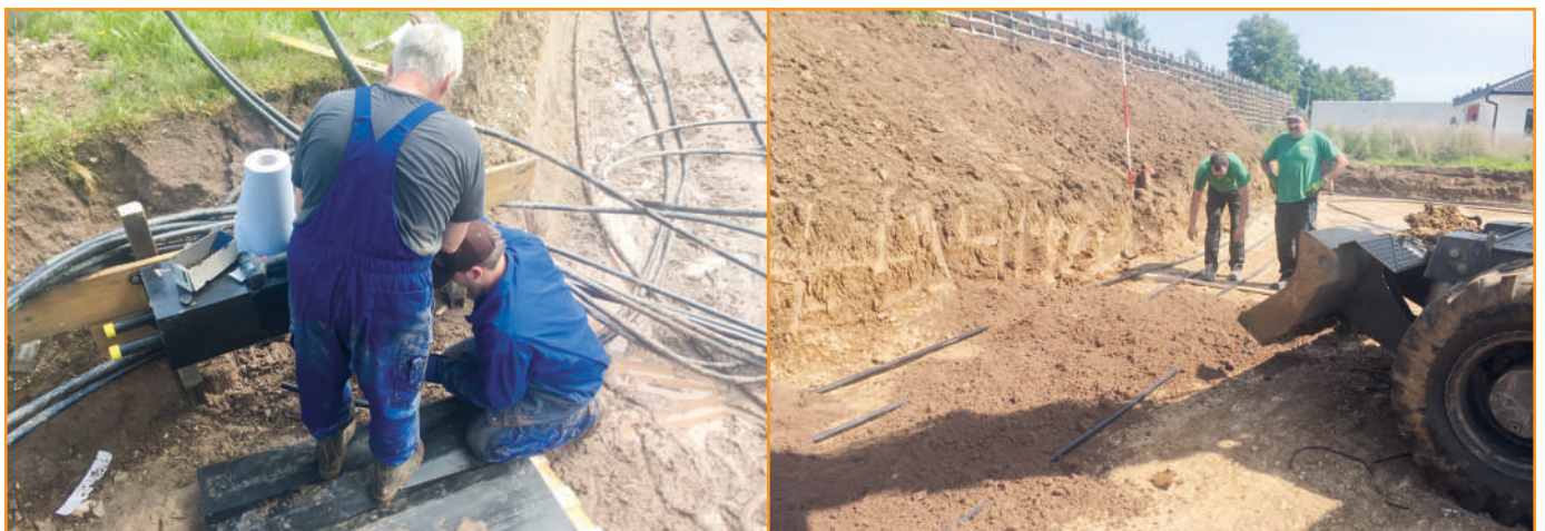
Wir unterstützen den Heizungsbauer bei der Planung und Umsetzung der unterschiedlichen Erdwärmesysteme. Quelle: Fischer Spezialbaustoffe GmbH
