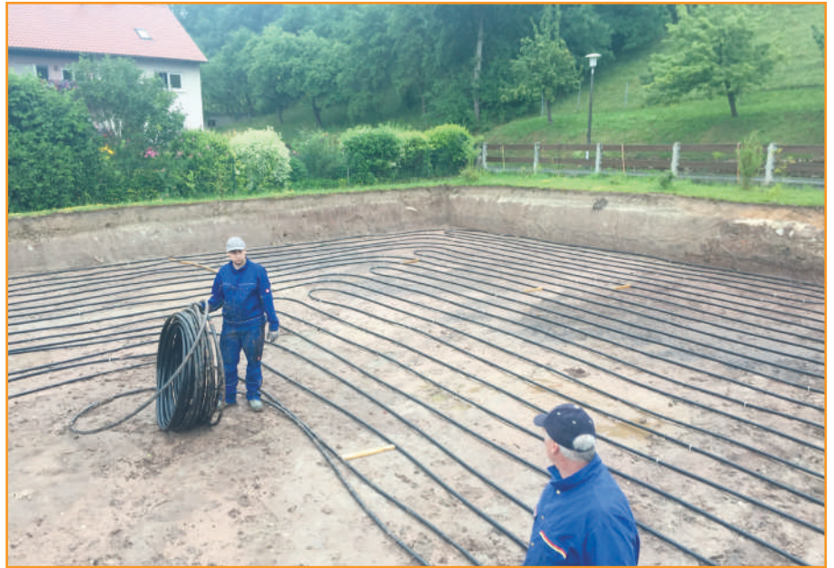
Der Heizungsbauer unter Anleitung des Fachplaners in Aktion. Quelle: Fischer Spezialbaustoffe GmbH
