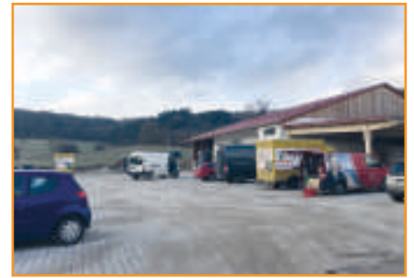
Parallel zu den Arbeiten am Kollektor konnte die Hoffläche noch vor dem Winter fertig gestellt werden.
