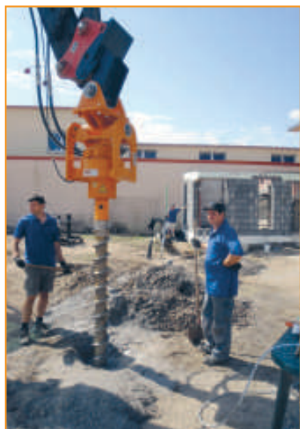
Eine Hohlbohrschnecke mit Bohrmotor.
