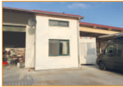
Aufenthalts- und Unterakunftsgebäude im Bereich der Lagerhalle. Hier wird im Sommer mittels Erdwärme klimatisiert.
