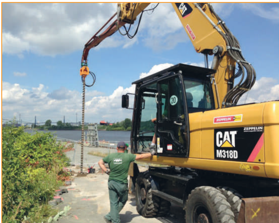
Ein Bohrmotor mit Schneckenbohrer bei einer Kampfmittelerkundung am Kanal.
