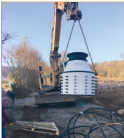
Verteilerschacht wird mit dem Bagger in die Grube gehoben.
