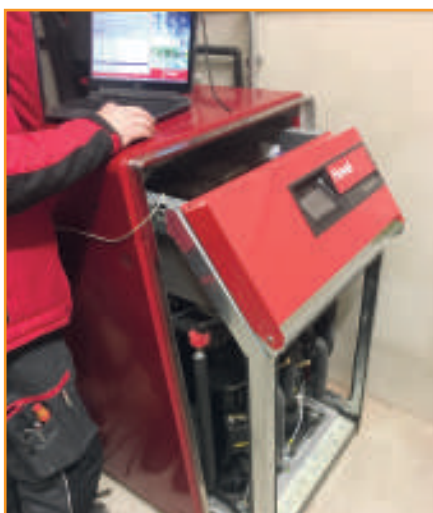
Inbetriebnahme der Wärmepumpe durch den Techniker der Firma HOVAL.
