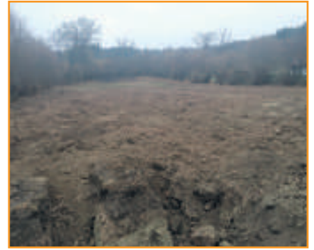
Das Flächenkollektorfeld kurz vor der Wiederherstellung durch den Bauherren.
