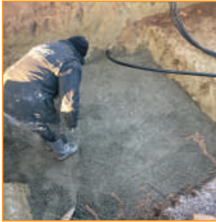
Fundament für den Verteilerschacht.
