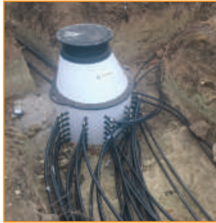
Schacht mit angeschweißten Leitungen zum Feld und zum Gebäude. Unter dem Schacht ist die Bodenplatte zu erkennen.
