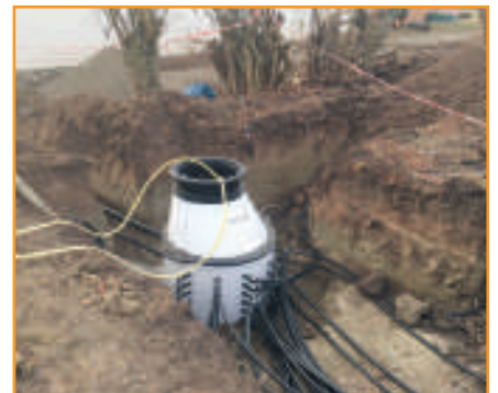
Spülen und Befüllen der Anlage. Durch das Einpumpen der Flüssigkeit wird die Luft in der Anlage verdrängt und die Dichtigkeit überprüft.
