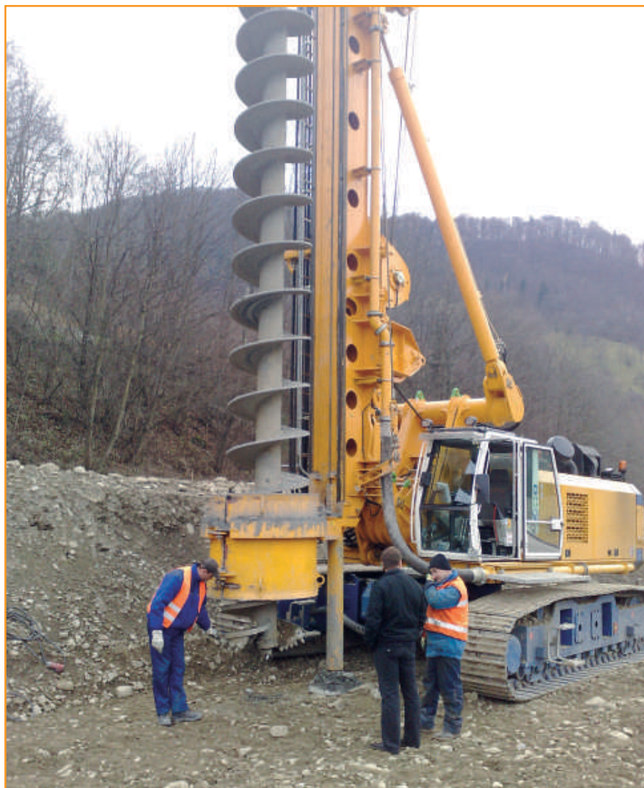
Ein Großdrehbohrgerät mit Schnecke zur Pfahlgründung.
