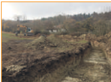
Erster Graben, hier wurden die Leitungen zusammengeführt.
