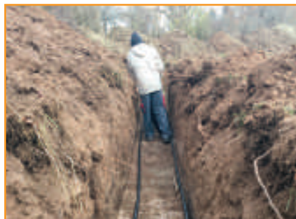
Leitungsgräben für Vor- und Rücklauf der einzelnen Kreisläufe.
