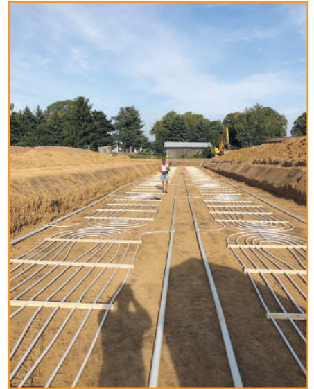
GPS-Einmessung des Energiefeldes.
