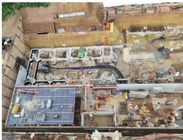
Luftaufnahmen der zehn Meter tiefen Baugrube.
