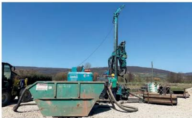
Baustelleneinrichtung mit Bohrgerät und Spülcontainer
