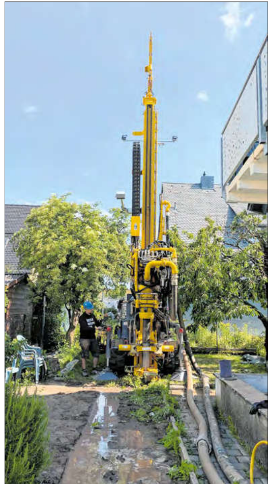
Erdwärme – hier eine Bohrung in einem Garten – kommt auch für Bestandsbauten im Betracht. Wichtig ist eine ausgefeilte, auf den Einzelfall abgestimmte Planung. Foto: Thomas Popp
