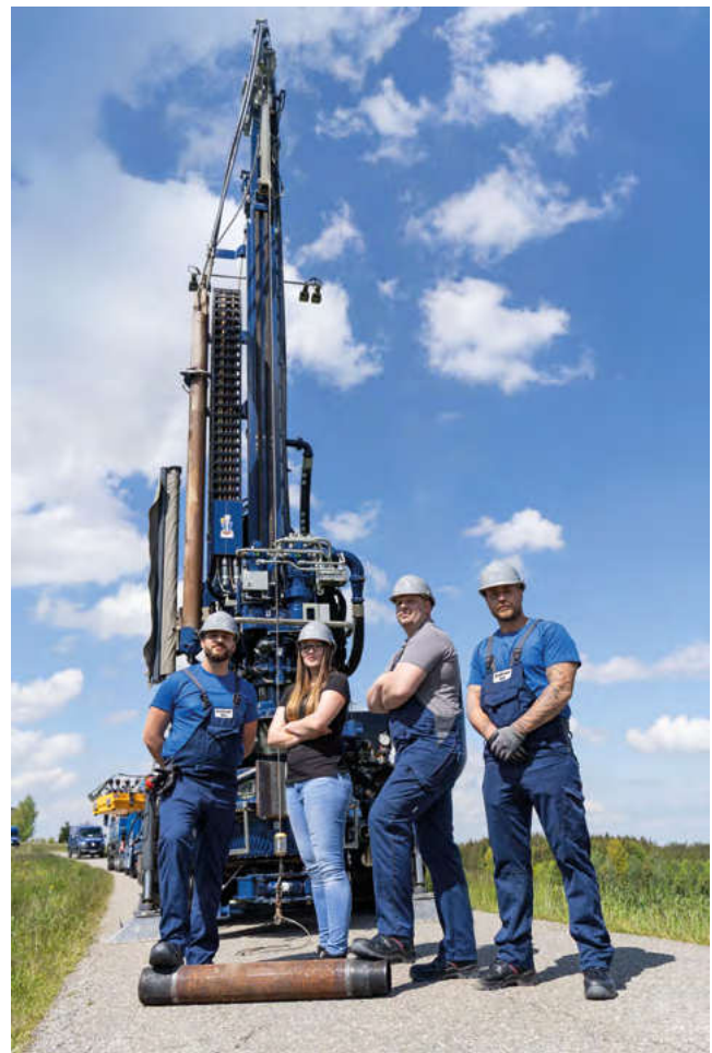
Ein Bohrteam von BauGrund Süd auf der Baustelle.
