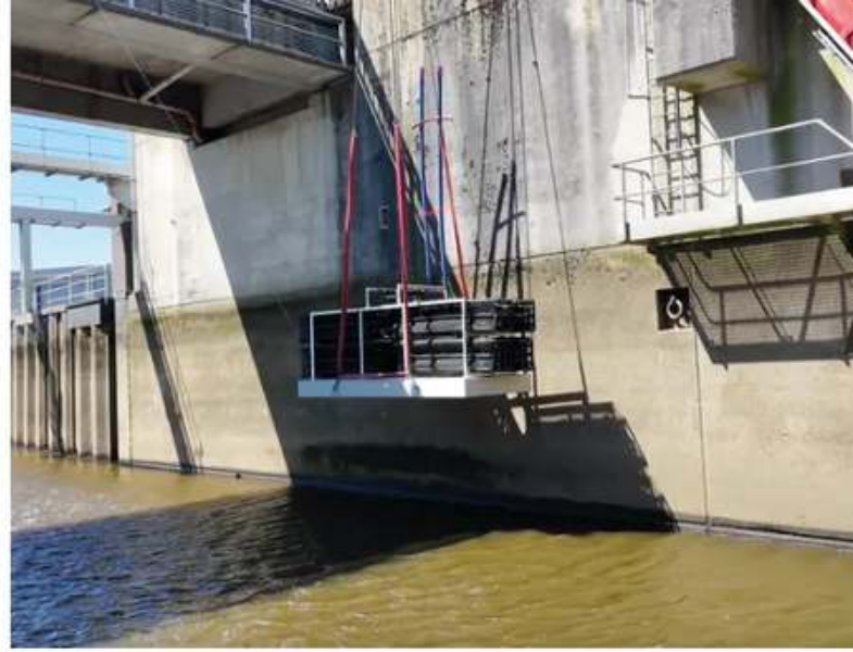
Abb. 2 und 3 Blick auf die Wärmetauscher, die mittels 80-Tonnen-Mobilkran an die vorgesehene Einbauposition gehoben wurden.
