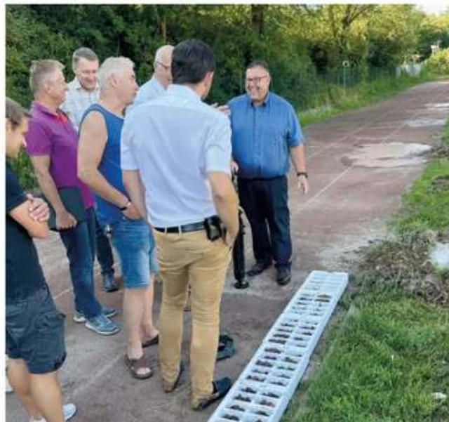
Abb. 7 Projektleiter Thomas Popp erklärt die einzelnen Schritte der Baustelle.
