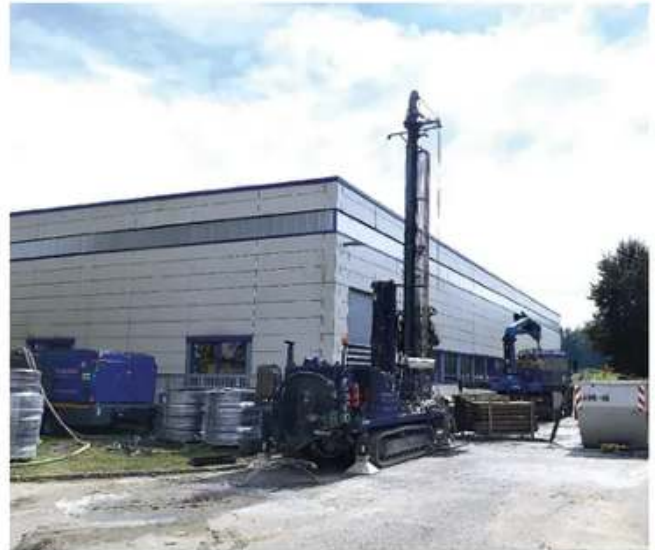
Abb. 1 Baustelleneinrichtung auf dem Firmengelände.
