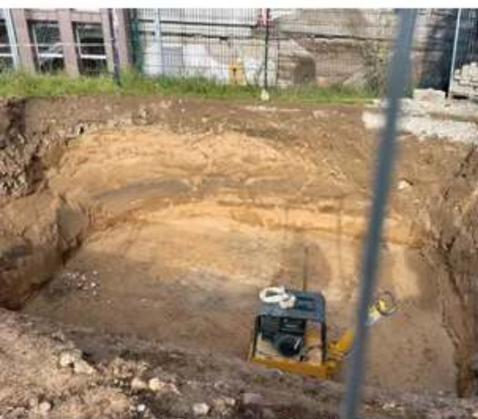
Abb. 16 Vorbereitung der Grube für die Verteilerschächte
