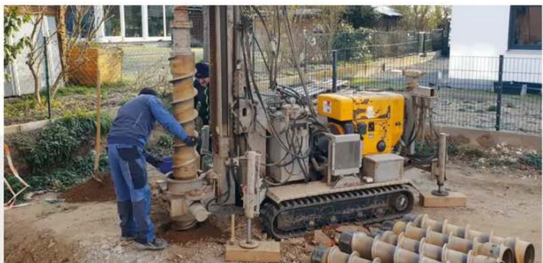
Abb. 1 Exemplarisch, kleines Bohrgerät mit Bohrschnecken, u.a. für Erdwärmebohrungen.
