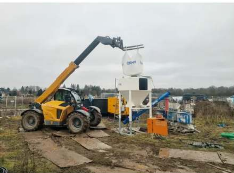
Abb. 1 Befüllung der Injektionsanlage mit BigBag auf einer Baustelle in Lüneburg.
