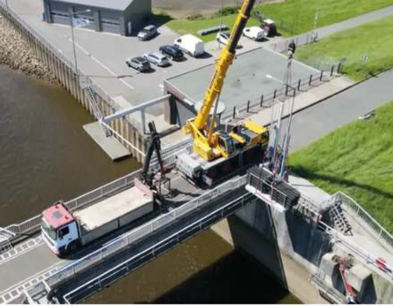
Abb. 2 und 3 Blick auf die Wärmetauscher, die mittels 80-Tonnen-Mobilkran an die vorgesehene Einbauposition gehoben wurden.
