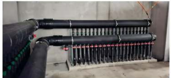
Abb. 4 Die Anlage wurde aufgrund der Größe vor Ort verschweißt.
