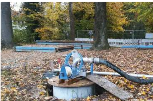
Abb. 4 Brunnenbauarbeiten am Rande eines Wohngebiets.
