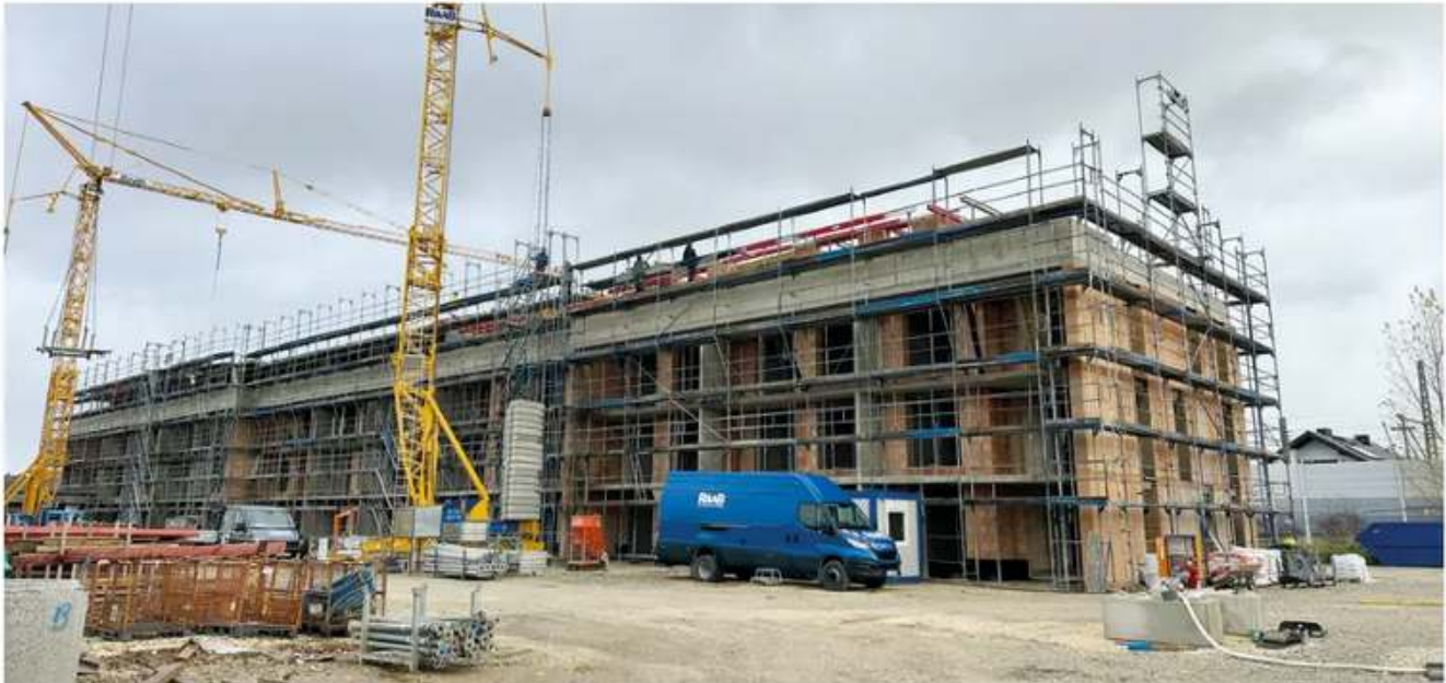
Abb. 1 Der Rohbau vom Gebäude „Servicewohnen“ der Raab Baugesellschaft mbH & Co. KG in Breitengüßbach.
