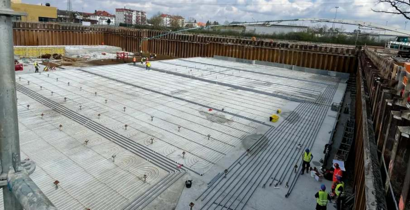
Abb. 1 Verlegung des Wärmetauschers auf dem Lagarde-Campus im oberfränkischen Bamberg.
