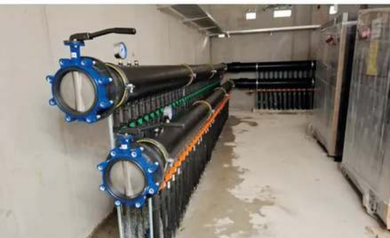
Abb. 5-7 Für den Neubau in Wädenswil wurde eine Verteileranlage mit 66 Abgängen mit einer weiteren mit 19 Abgängen kombiniert.
