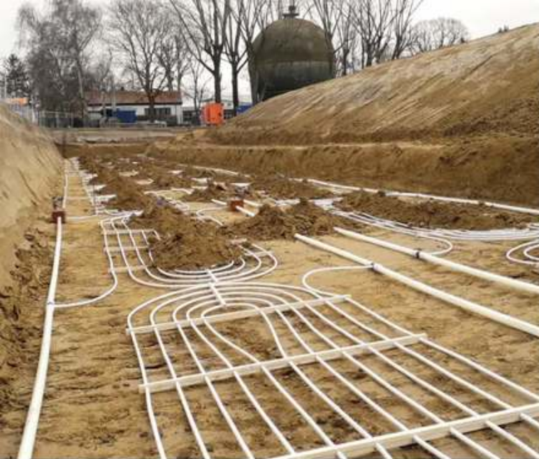
Abb. 3 Einbau der Kollektorstränge in Bad Nauheim. Fotos: FAU / Steinhäuser GmbH & Co. KG
