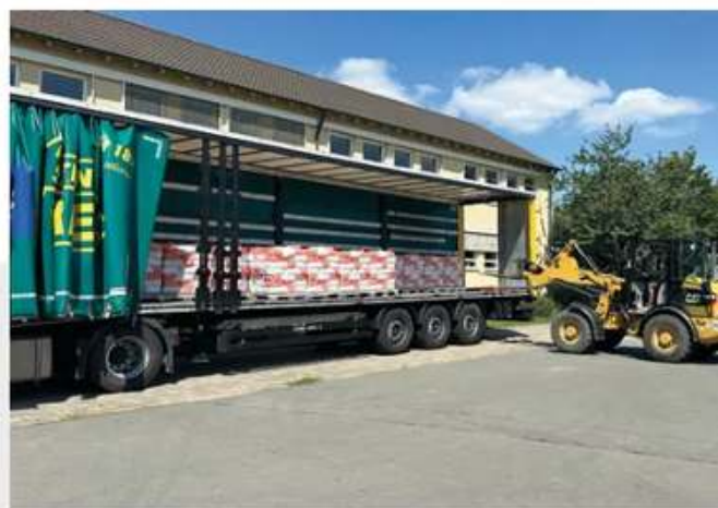
Abb. 6 Termingerechte Anlieferung der benötigten Materialien.
