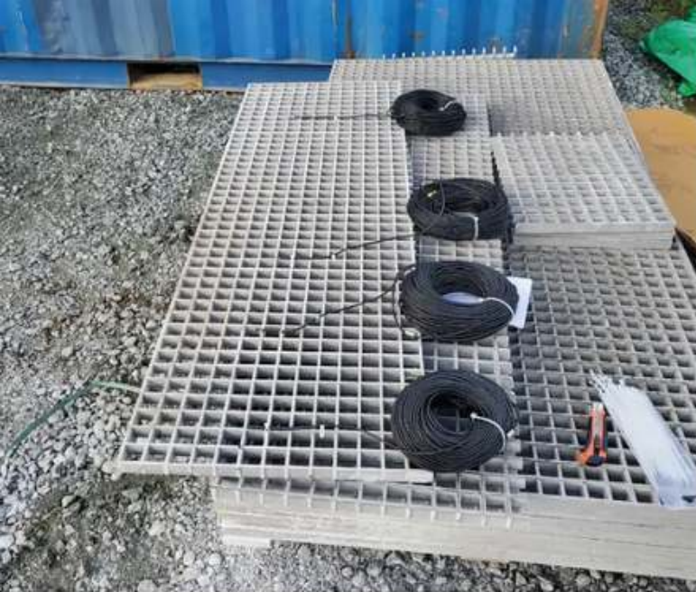
Abb. 1 Gitter mit Messtechnik vor und nach dem Einbau. Fotos: FAU
