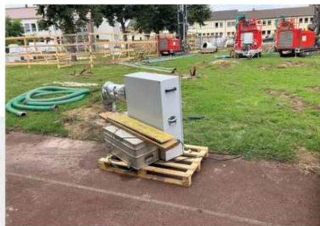
Abb. 14 Thermal-Response-Test an der ersten Bohrung
