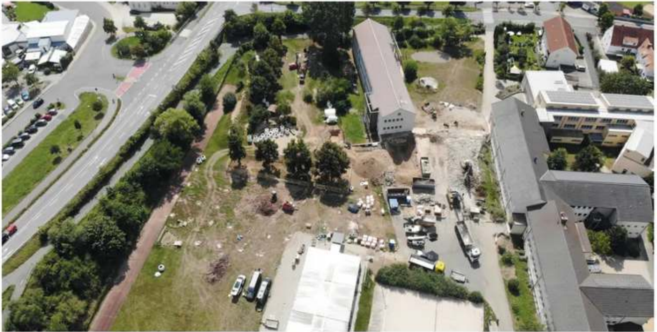
Abb. 15 Blick aus der Vogelperspektive auf das Bohrfeld am Schulzentrum in Hirschaid
