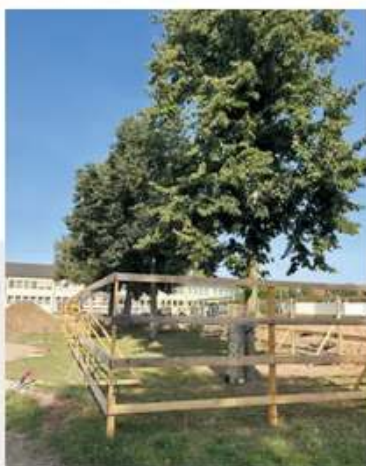
Abb. 9 Baumschutz für den vorhandenen Baumbestand.
