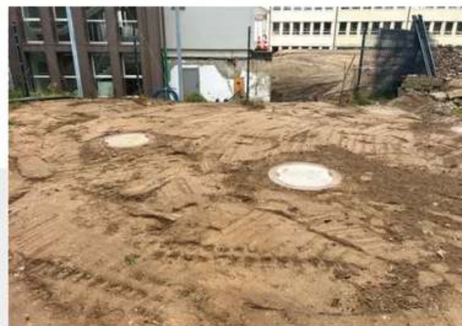
Abb. 22 Geländeoberfläche der eingebauten Verteilerschächte.
