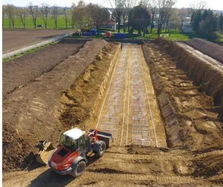
Abb. 3 Einbau der Kollektorstränge in Bad Nauheim. Fotos: FAU / Steinhäuser GmbH & Co. KG
