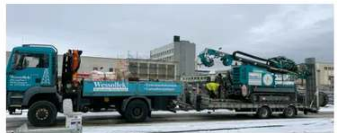
Abb. 1 Bohrgerät der Firma Wessollek bei der Anlieferung.
