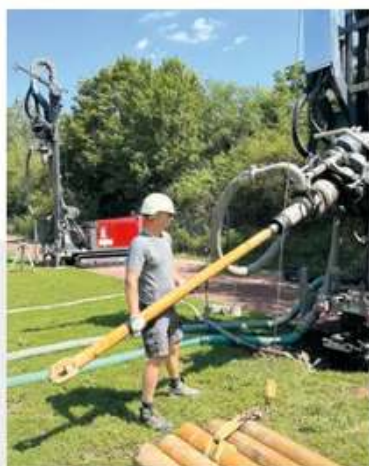
Abb. 4 Einsetzen des Bohrmeißels an der Bohranlage.
