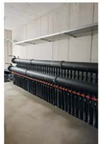
Abb. 5-7 Für den Neubau in Wädenswil wurde eine Verteileranlage mit 66 Abgängen mit einer weiteren mit 19 Abgängen kombiniert.
