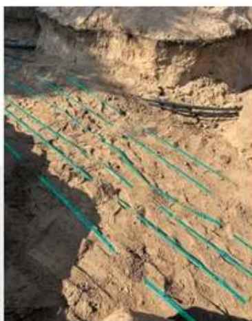
Abb. 20 Warnband zum Schutz der verlegten Anbindeleitungen.
