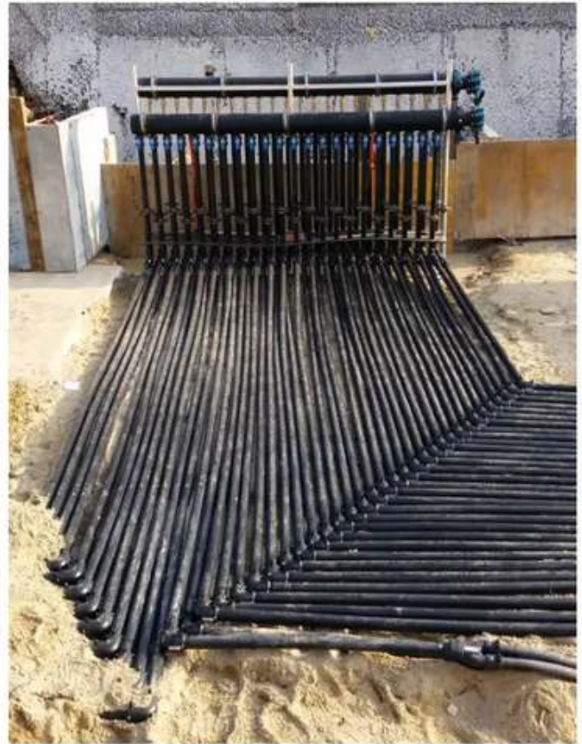
Abb. 2 und 3 Rund 200 Wohneinheiten verteilt auf fünf Neubau-Objekte werden künftig von insgesamt 75 Erdsonden versorgt.
