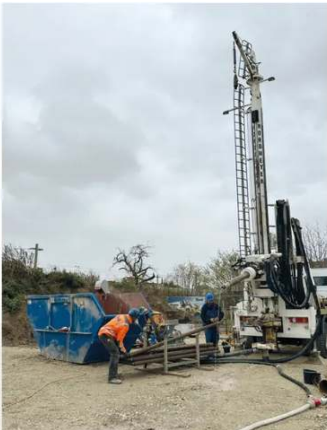
Abb. 2 Das Bohrgerät beim Gestängewechsel.
