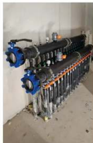
Abb. 5-7 Für den Neubau in Wädenswil wurde eine Verteileranlage mit 66 Abgängen mit einer weiteren mit 19 Abgängen kombiniert.
