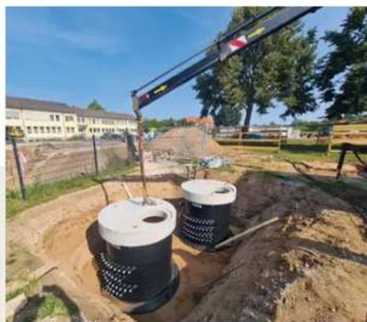
Abb. 17 Platzieren der beiden Verteilerschächte in der vorbereiteten Baugrube
