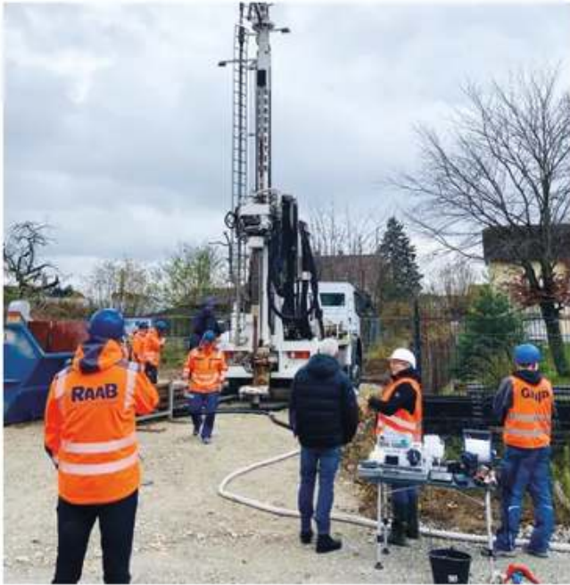
Abb. 1 Die Pilotbohrung im Rahmen der Zertifizierung von Bohrfirmen nach dem DVGW Merkblatt W 120.
