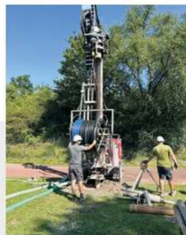
Abb. 10 Einbau der Erdwärmesonde.
