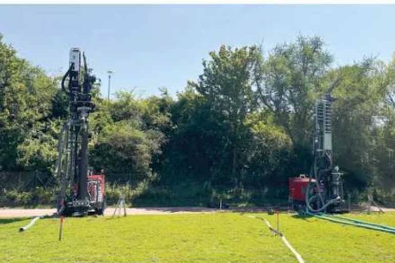
Abb. 3 Baustelleneinrichtung mit zwei Rotomax Li-Bohrgeräten.
