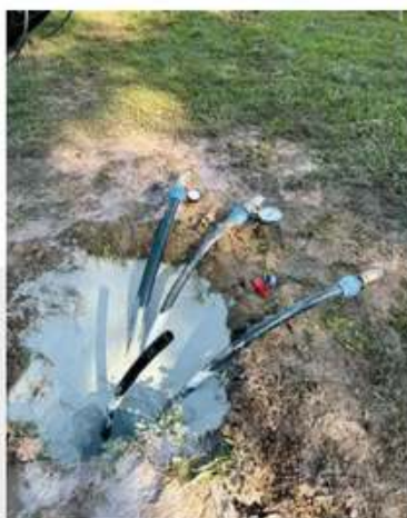
Abb. 12 Fertig verfülltes Bohrloch mit Fischer GeoSolid 240 HS
