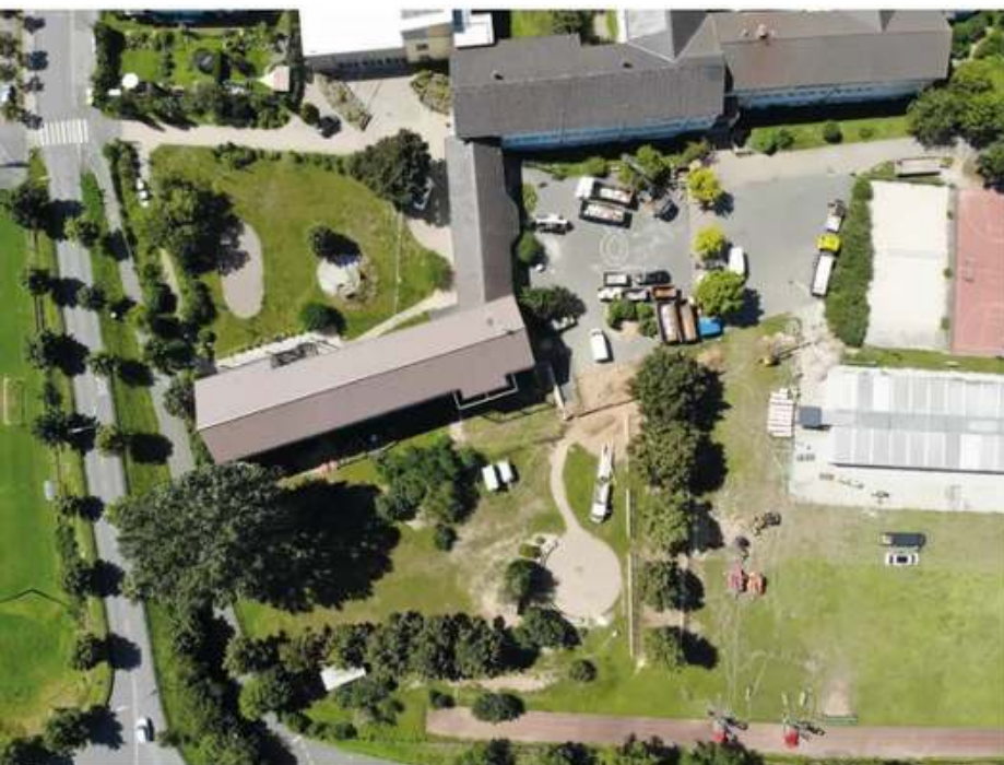
Abb. 1 Blick von oben auf die Baustelle. Zu sehen sind beide Bohranlagen zum Start der Baumaßnahme.
