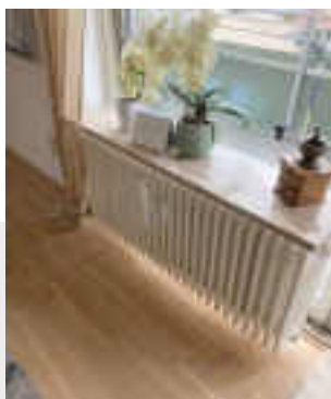
Abb. 1 Alte Heizkörper mit neuen Ventilen.
