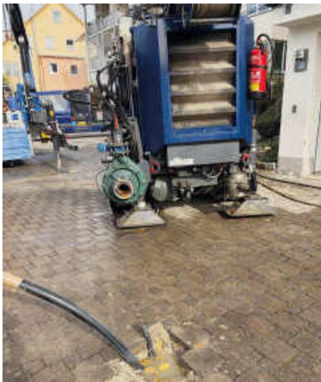
Abb. 5 Nach dem Bohren ist vor dem Anschliessen.
