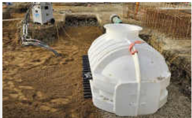
Abb. 5 Einbau eines GN-X2 Verteilerschachts auf der Baustelle.
