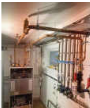
Abb. 2 Die Wärmepumpenmontage im Heizraum.
