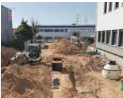
Abb. 1 Blick auf die Baustelle mit Verteilerschacht.
