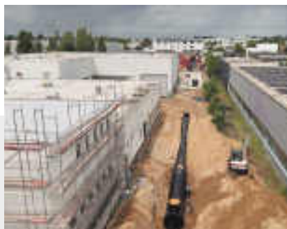
Abb. 2 Blick auf die Halle und den THERMTANK.
