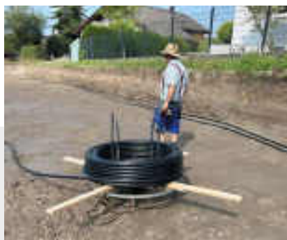
Abb. 2 Leichtes Verlegen der Rohre mit einer Haspel.
