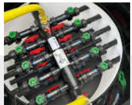
Abb. 9 Befüllung der Anlage mit Wärmeträgermedium.
