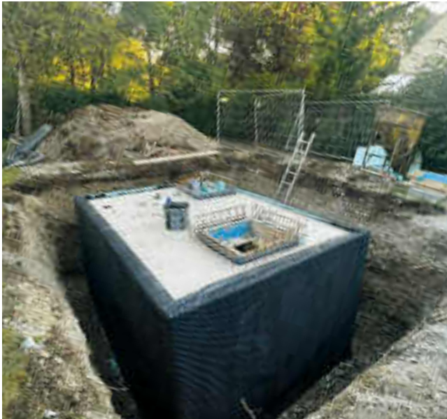
Abb. 2 Brunnenstube (Schacht) in der Blumenauer Straße.
