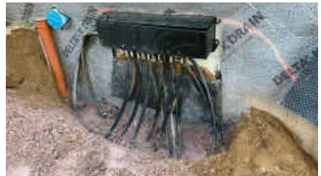
Abb. 6 Eine Variante des Hausanschlusses: Der Wandanschlusschacht.
