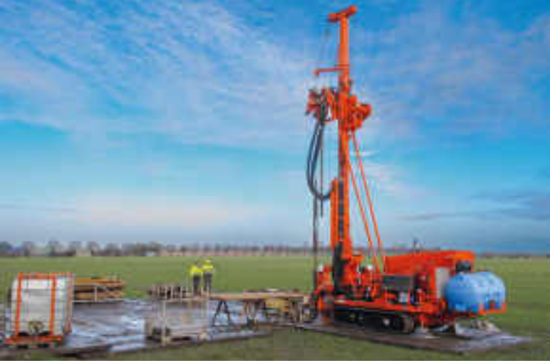
Abb. 7 Bohrplatz im Schutzgebiet mit entsprechender Schutzeinrichtung.
