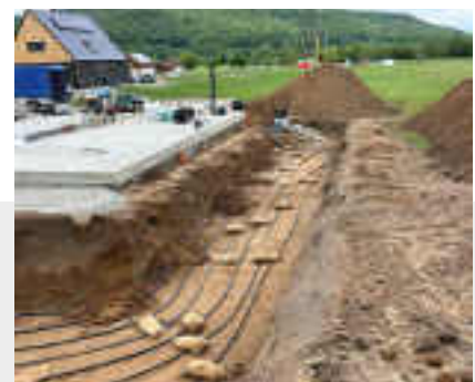
Abb. 3 Verlegung eines Kollektors im Neubau.
