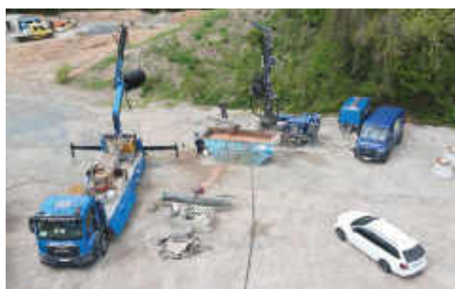
Abb. 1 Baustelleneinrichtung der Firma BauGrund Süd.
