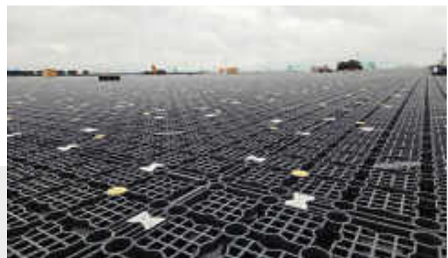
Abb. 11 Der Unterbau für Versickerungsflächen.
