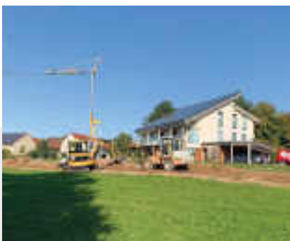
Abb. 1 Baustelleneinrichtung für den Bau eines Flächenkollektors.
