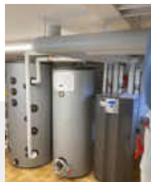
Abb. 4 Die Installation ist abgeschlossen.
