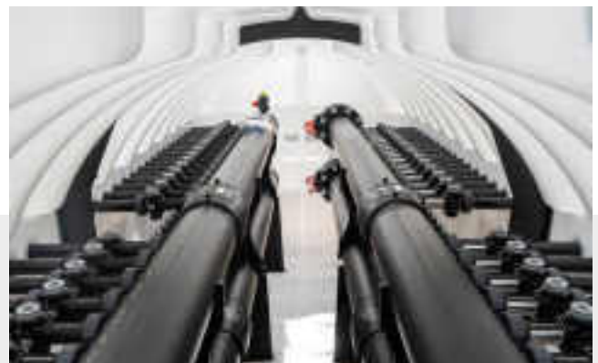
Abb. 2 Innenansicht eines Verteilerschachts der GN X4 - Serie.
