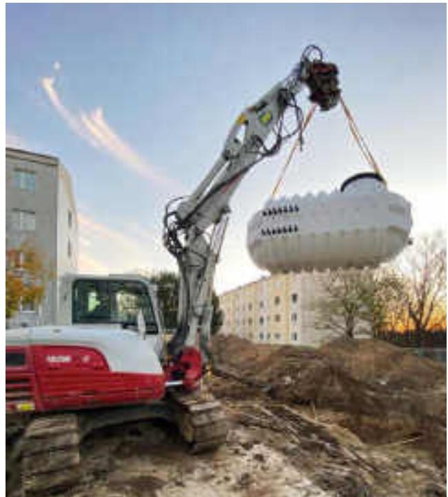
Abb. 4 Einbau eines GN-X2 Verteilerschachts auf der Baustelle.
