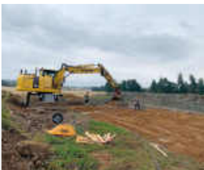
Abb. 7 Abdecken der Kollektorrohre mit Sand.
