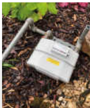
Abb. 3 Gasanschluss raus - Erdwärme rein.
