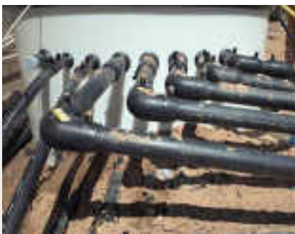
Abb. 5 Die einzelnen Kreise wurden mit dem Verteilerschacht verbunden.
