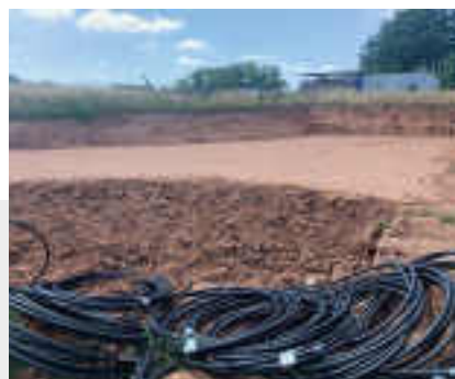
Abb. 8 Ein Flächenkollektor nach der Verlegung, teilverfüllt.
