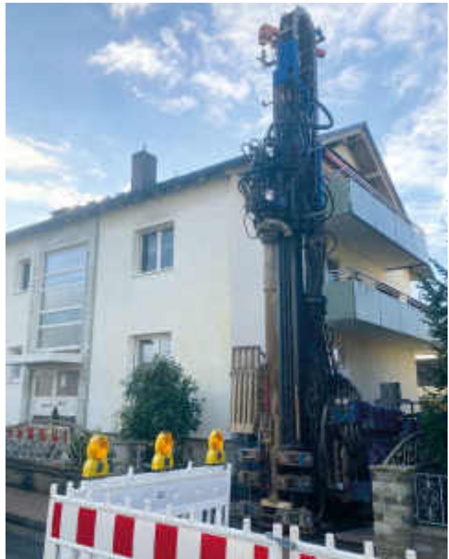
Abb. 5 Die laufenden Bohrarbeiten in der Hofeinfahrt - drei Bohrungen á 99 Meter im Festgestein wurden durchgeführt.
