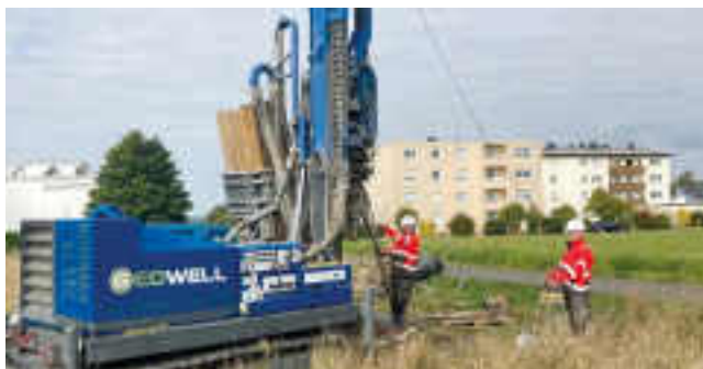
Abb. 1 Modernes Bohrgerät von Geowell im Einsatz.
